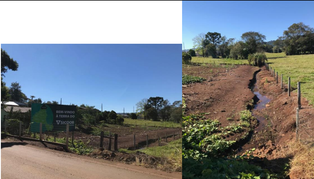
Figura: 8: Imagem demonstrando o Ponto 2 vistoriado, com destaque para a casa onde houve alagamentos
