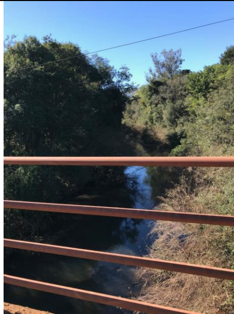
Figura: 63: Ponte do Rio Cafundó
