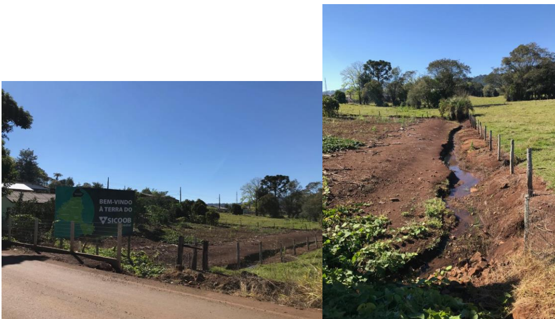
Figura: 47: Imagem demonstrando o Ponto 2 vistoriado, com destaque para a casa onde houve alagamentos
