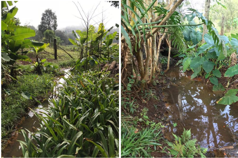
Figura: 70: Drenagem identificada na vistoria in loco
