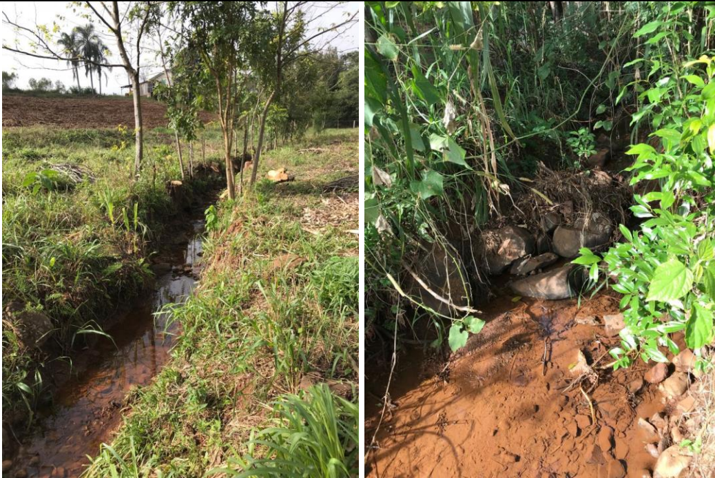
Figura: 74: Localização da drenagem aos fundos da residência, e término da canalização.
