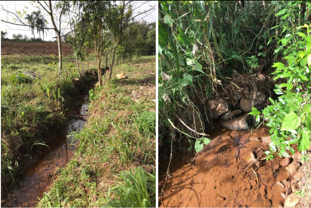
Figura: 35: Localização da drenagem aos fundos da residência, e término da canalização.
