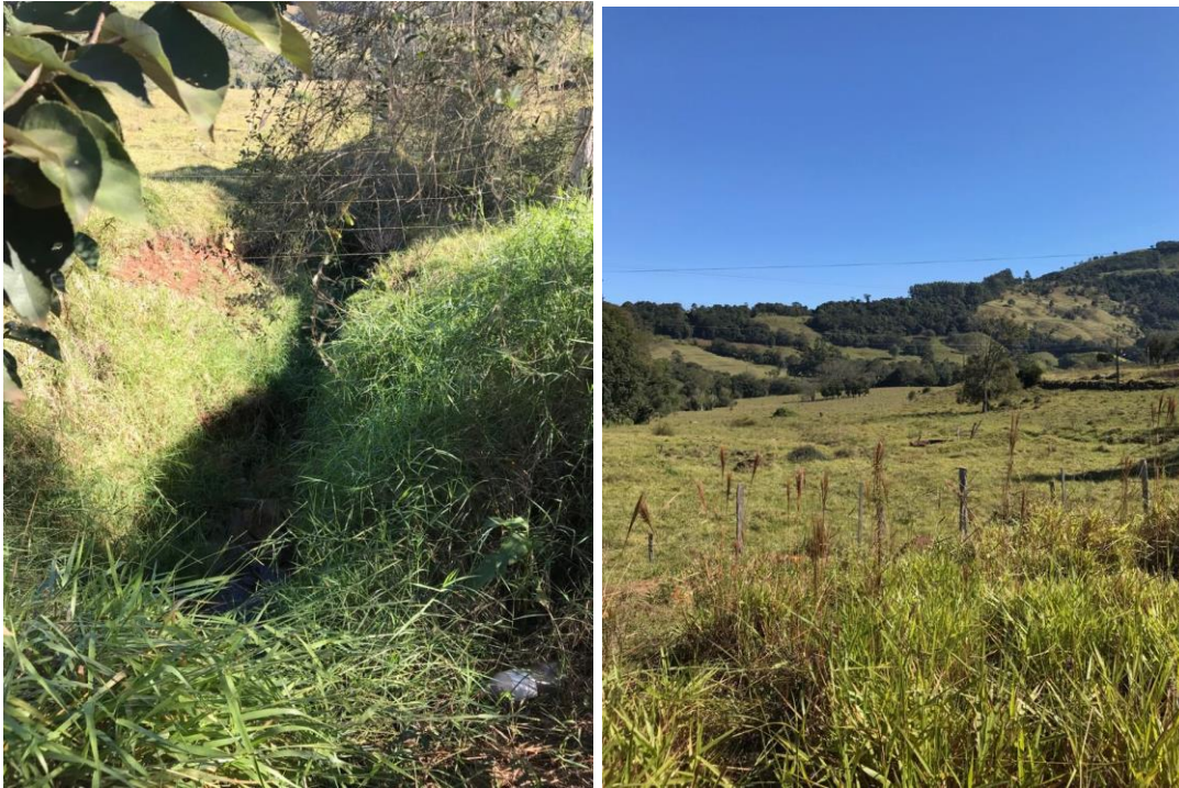
Figura: 48: Imagem demonstrando o Ponto 3 vistoriado
