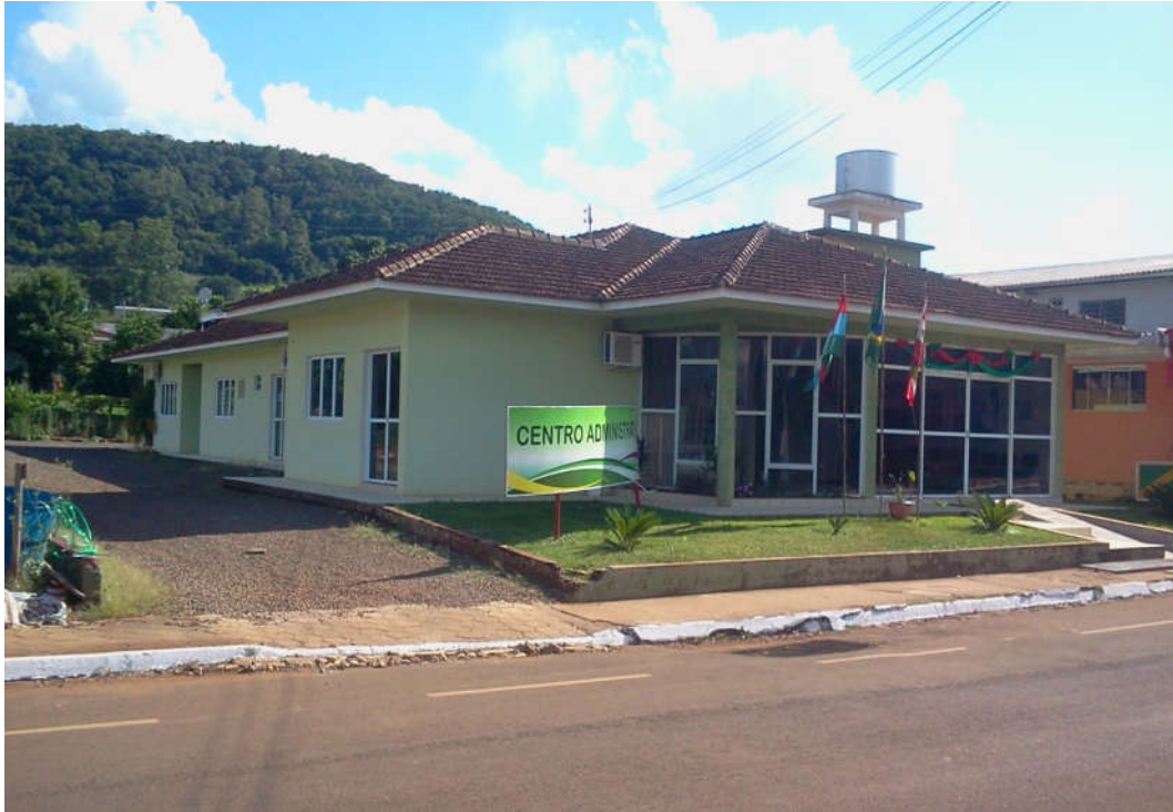
Centro Administrativo do Município de Santa Terezinha do Progresso
